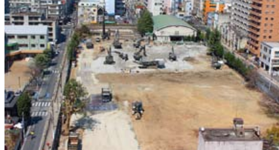
▲解体作業工事
