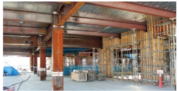
6階の工事風景
