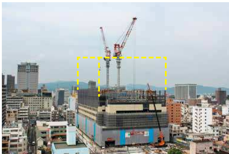
工事全景（平成27年7月3日撮影）
