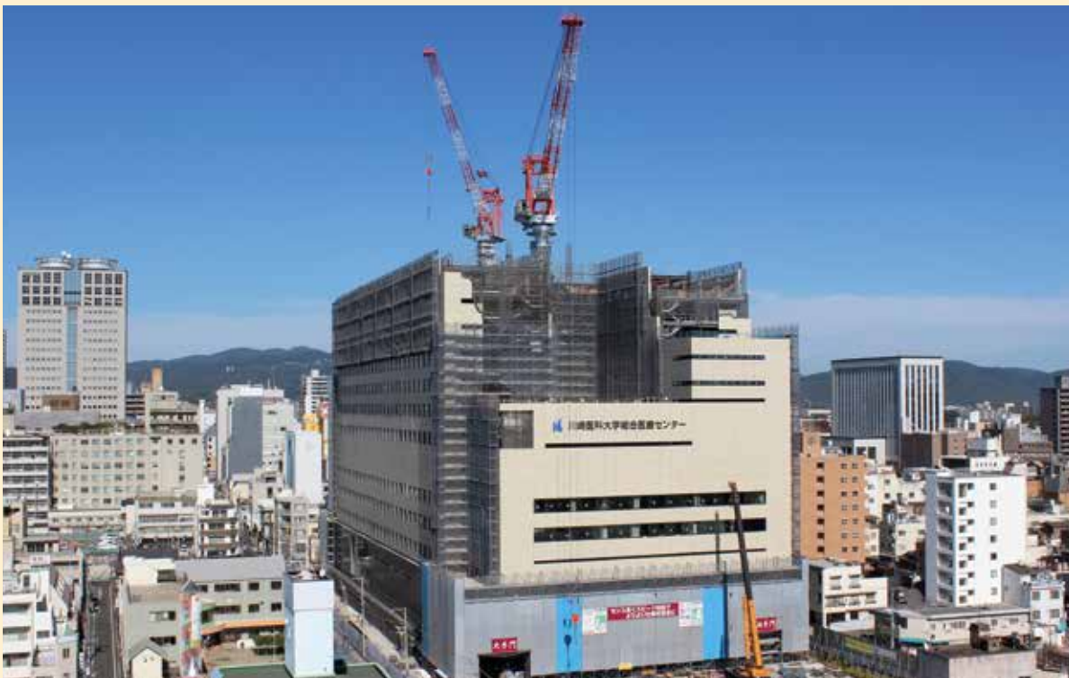
工事全景（平成27年10月26日撮影）
