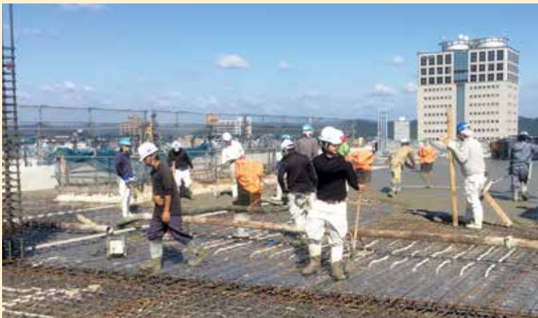
14階工事風景（コンクリート打設）
