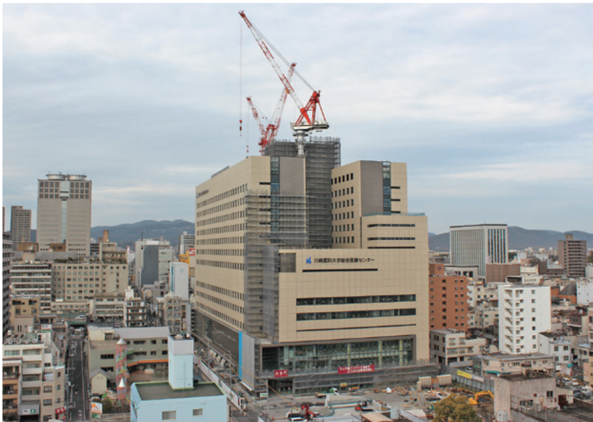
工事全景（平成28年2月22日撮影）
