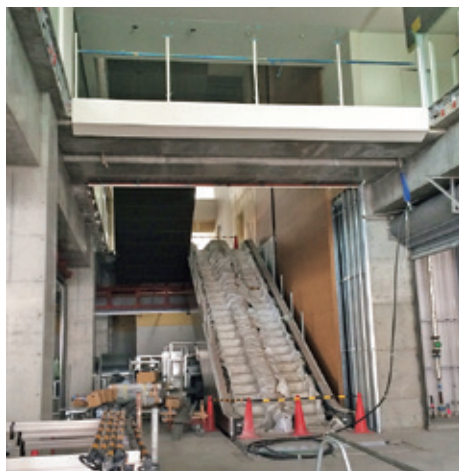
外来エスカレーターの設置工事
