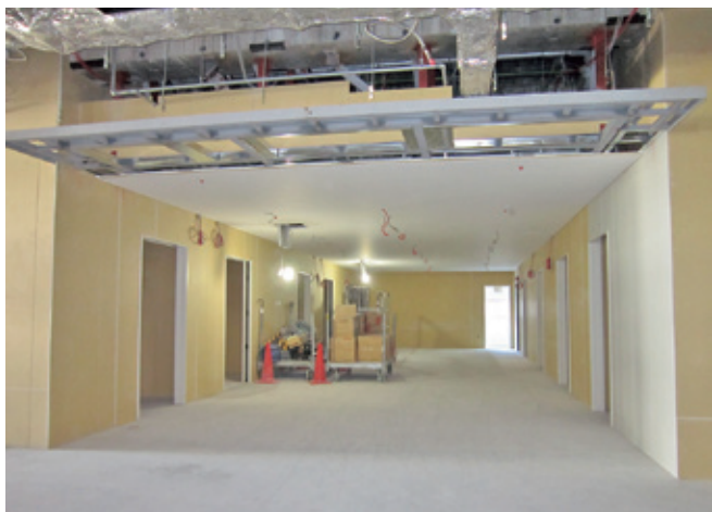
2階外来診察室前（内装工事の様子）
