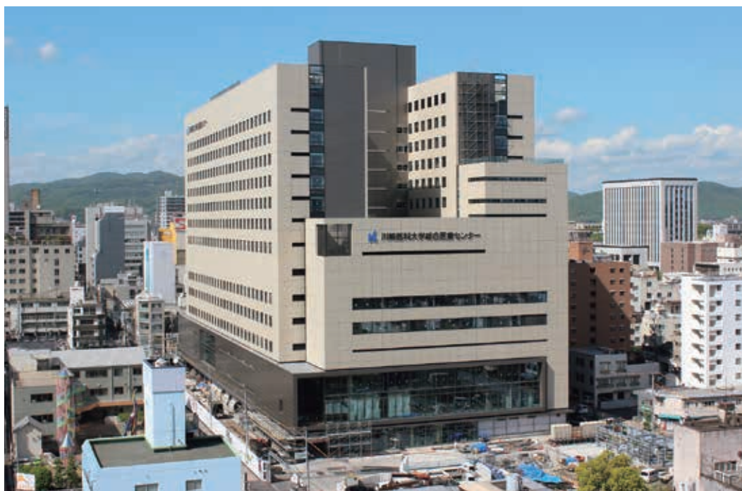
工事全景（平成28年4月22日撮影）
