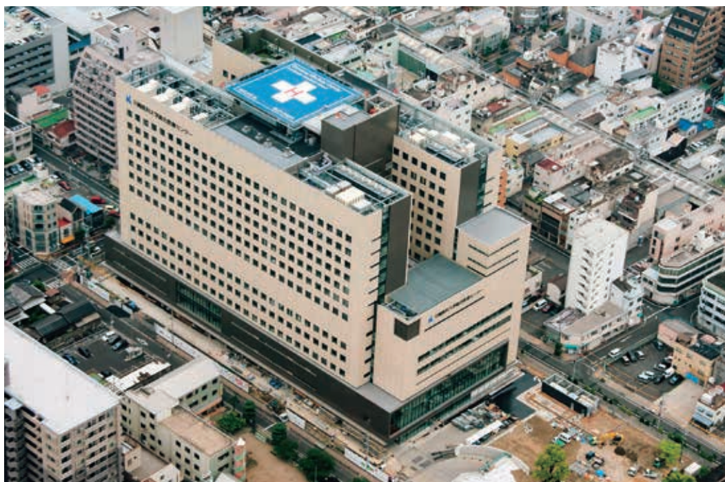
工事全景（航空写真：平成28年5月20日撮影）
